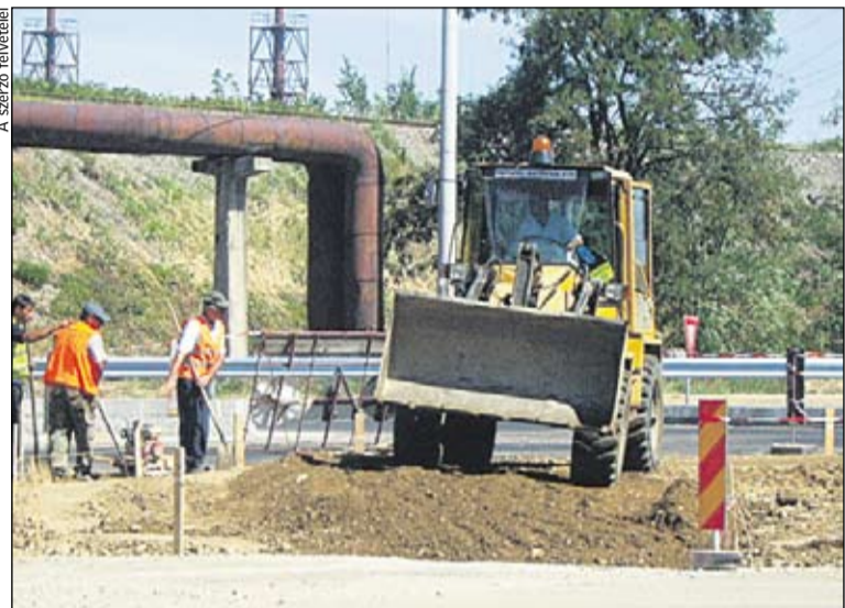
A munkások a rekkenő hőségben is dolgoznak a Podului utcán
